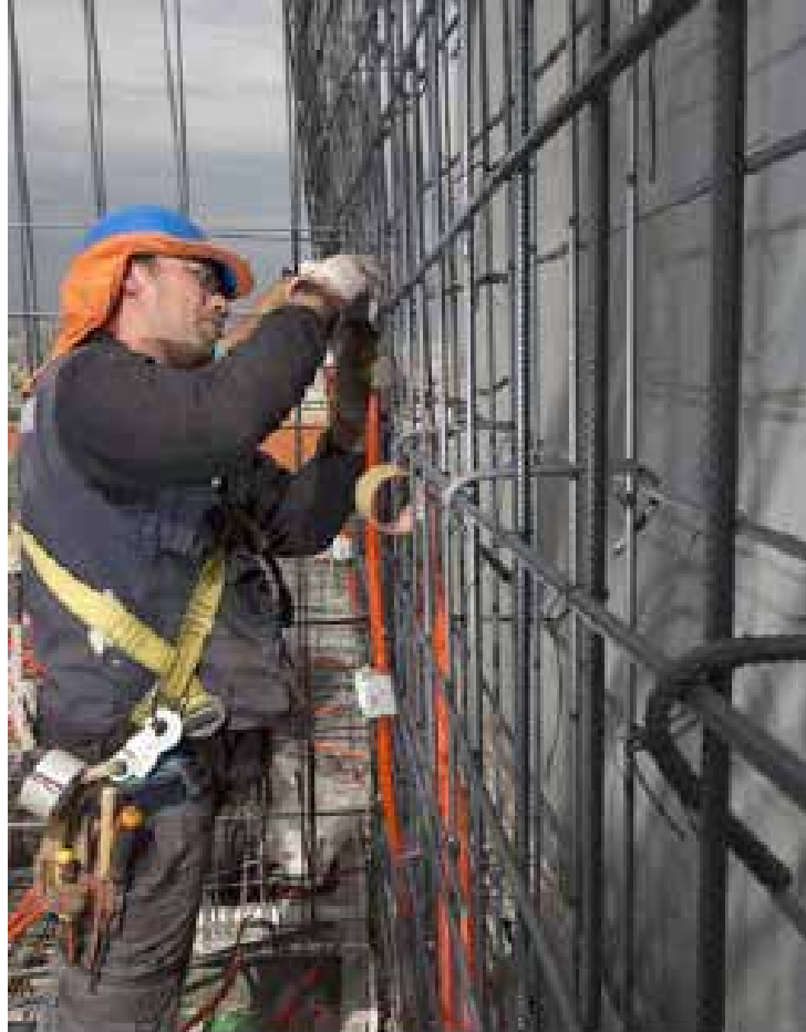
Construcción proyecto "Centro Alameda"/ Estación Central, Santiago
